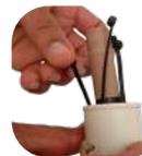
10. Para fixar as abraçadeiras de nylon use uma ou duas abraçadeiras de metal que abre até 1 polegada. Aperte-a bem com uma chave de fenda, ou melhor ainda, com uma chave de boca.
